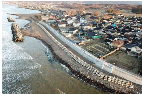
完成した護岸改良工②
