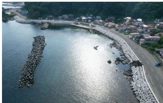
完成した護岸改良工①
