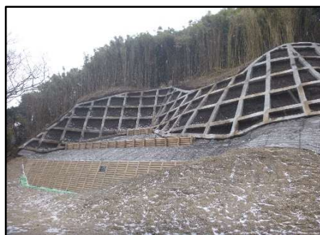
完成した山腹工
