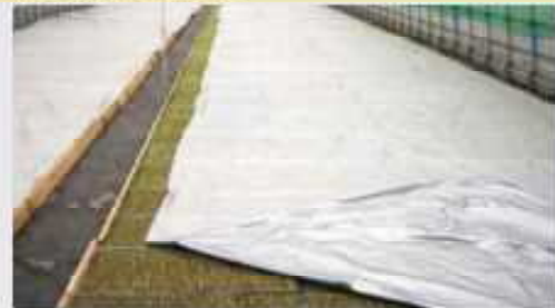
緑化始期：べた張り除去の様子
