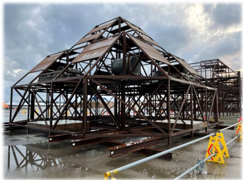
魚礁の整備工事
