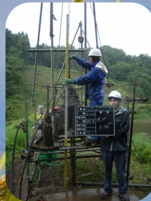
ボーリング調査
