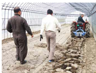
心土破碎施工の様子
