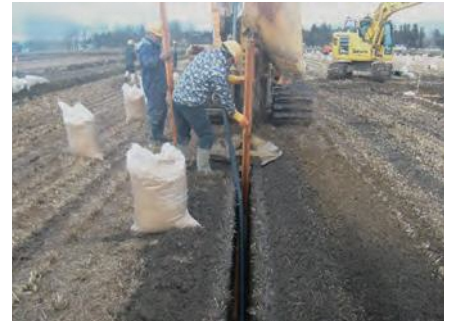
暗渠排水の整備
