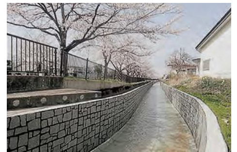
旭川左岸幹線用水路 (施工後)
