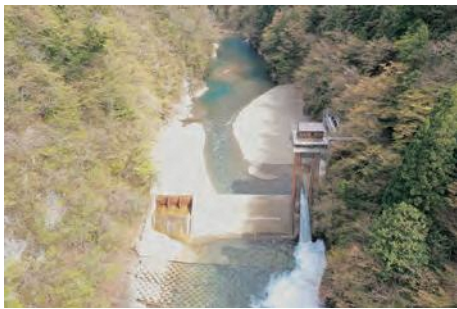
抱返頭首工（施工中）
