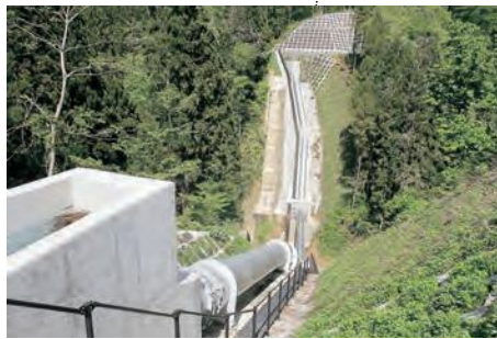
第二田沢幹線用水路（施工後）
