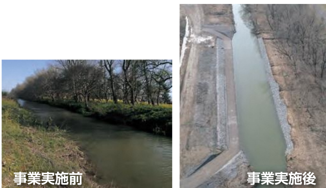
E1 支線排水路沈砂池
