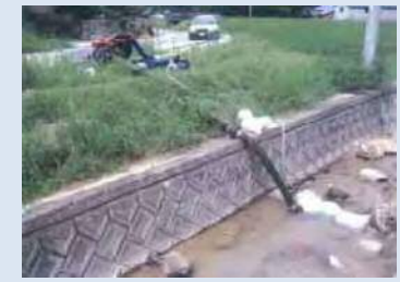
仮設ポンプを設置し、用水を確保
