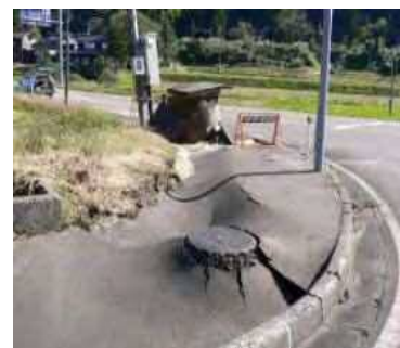
地震により被災した集落排水施設
