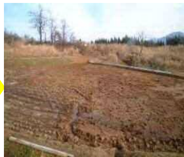
査定前着工により復旧した農地
