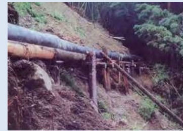
仮設水路を設置し、用水を確保
